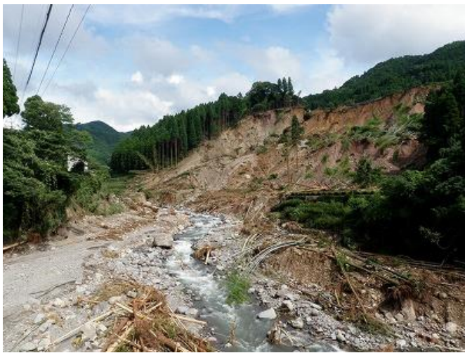
山全体が土砂崩れ。深層崩壊の様子
