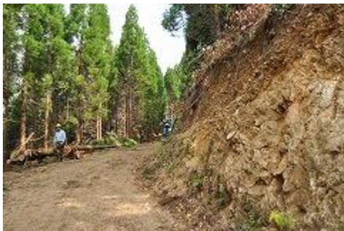
(1)諸塚村内の作業路
