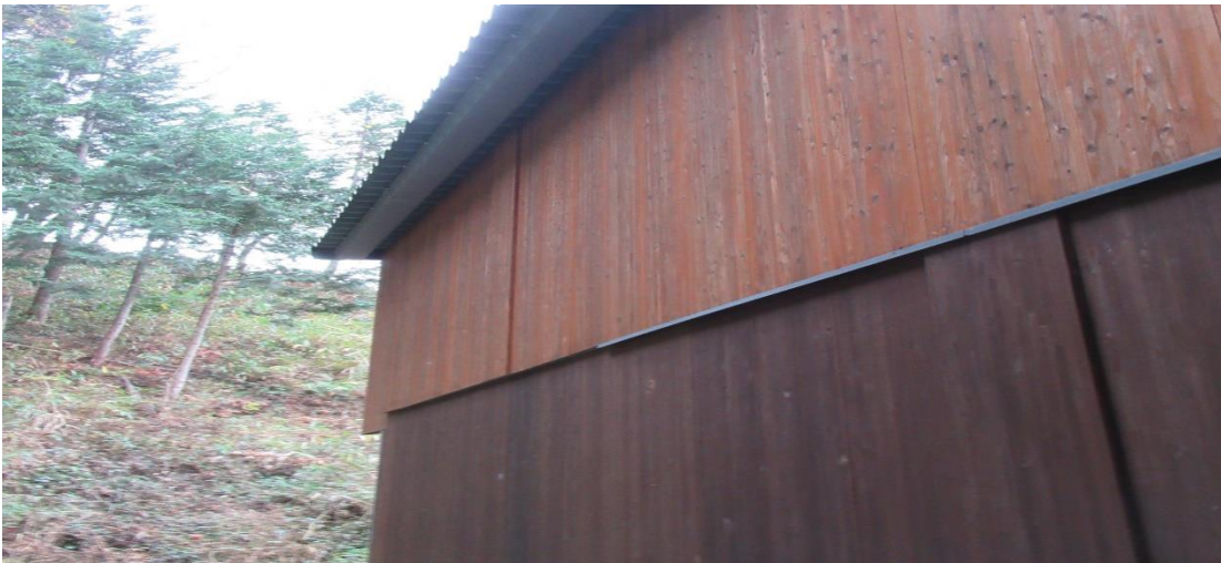
（WOODALC倉庫 現地見学会風景）
